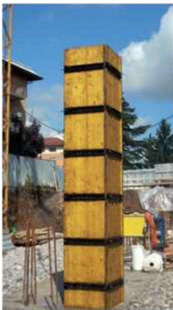
funzione della resistenza richiesta; vengono poi inserite le staffe che legano tali ferri longitudinali. A questo punto viene montata la lacassaforma, una struttura scatolare in legno, attorno ai ferri.
